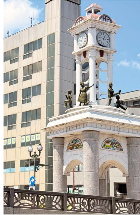
「かながわの橋100選」に選定されている 「まほろば大橋」のからくり時計塔
