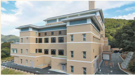
11 平成25年(2013年) はだのグリーンセンターが本格稼働
