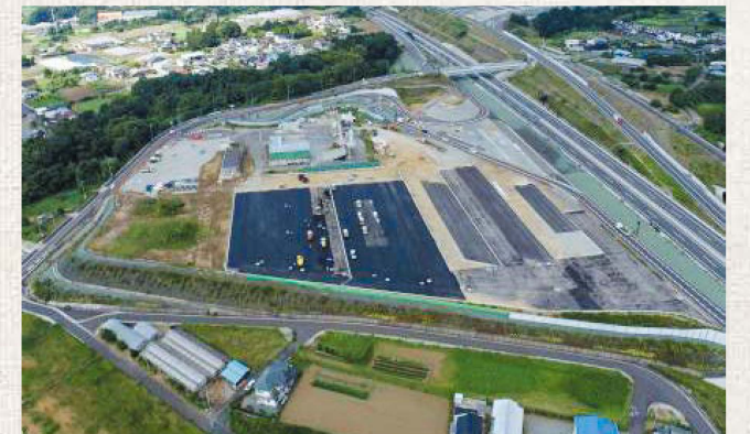
秦野丹沢SA下り(工事中)
