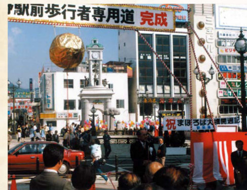
6 平成元年(1989年) まほろば大橋が完成
