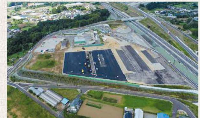
秦野丹沢 SA 下り (工事中)
