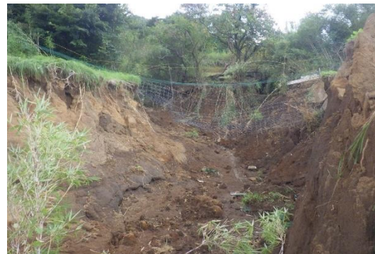
名古屋大塚農道の被害状況
