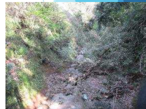
矢坪沢水路整備事業 延長890m
