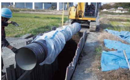
管路耐震化の現場
