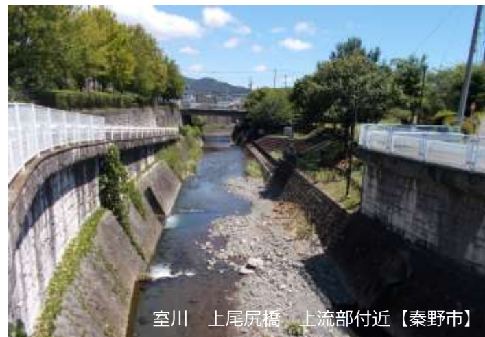
道路側の擁壁の事例
