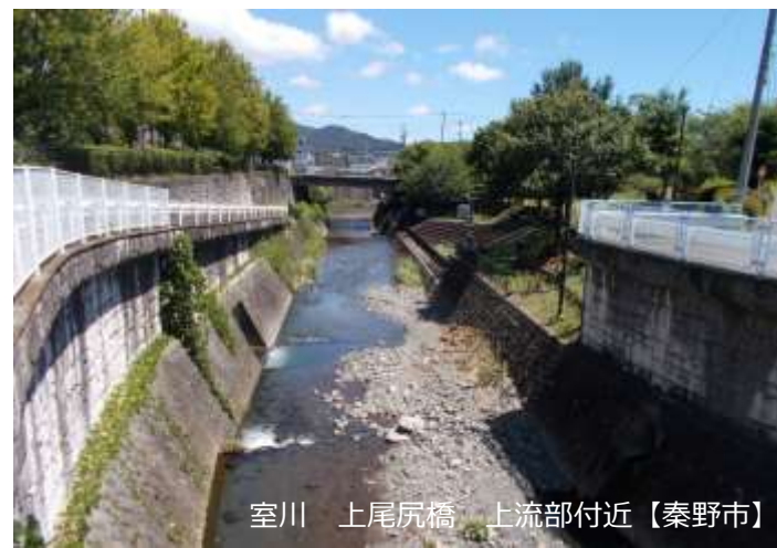
道路側の擁壁の事例
