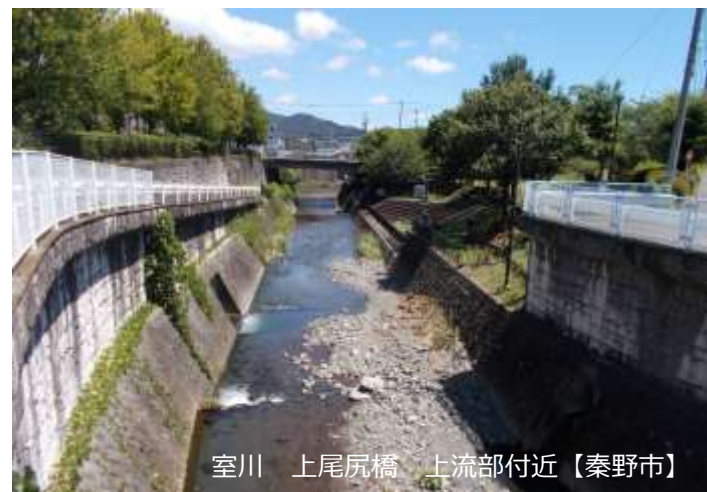
道路側の擁壁の事例
