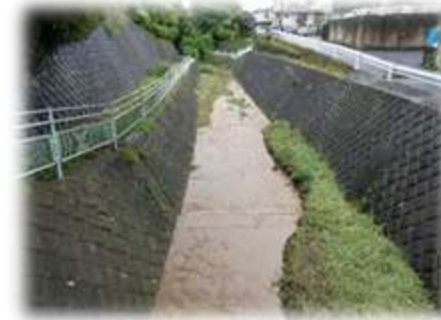
写真：下流側整備済み区間
