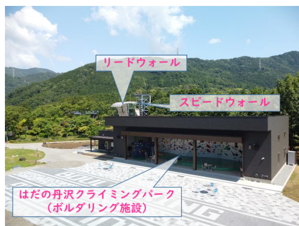
はだの丹沢クライミングパーク（手前）と県立山岳スポーツセンターのリードウォール（左奥）及びスピードウォール（右奥）
