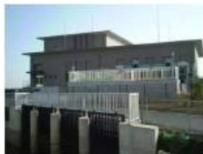
大根川ポンプ場
