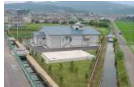
鶴巻中継ポンプ場
