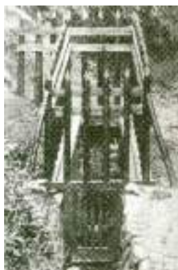
曾屋水道創設時から使用されていた水源（ロ号水源）
