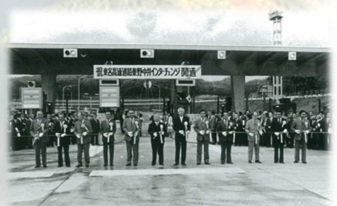
東名高速道路 秦野中井インターチェンジ完成の様子
