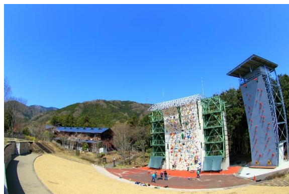
改修されたリード施設〔中央〕と新設されたスピード施設〔右側〕（県立山岳スポーツセンター）
