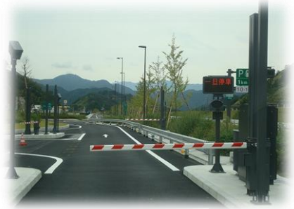
【静岡 SA スマートIC (新東名高速道路)】
