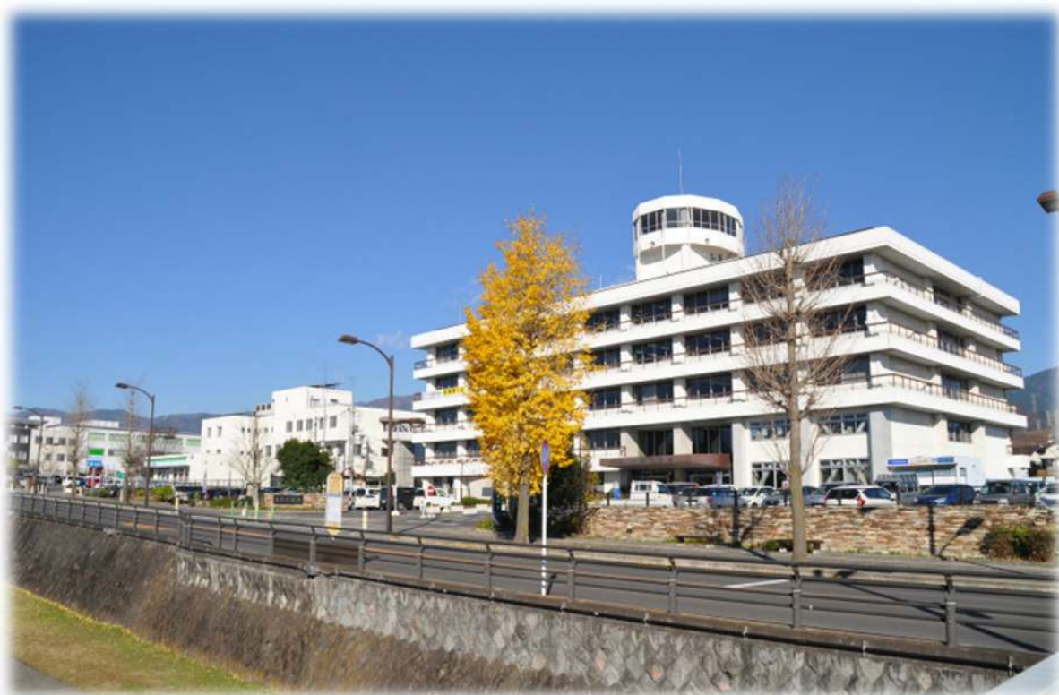
秦野市役所本庁舎
