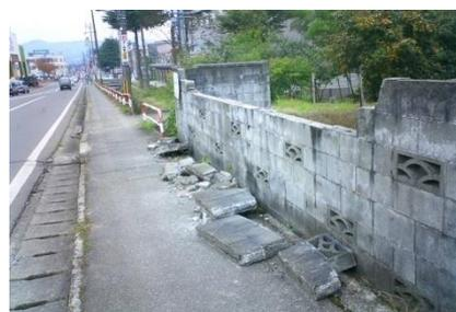
平成16年 新潟県中越地震によりブロック塀が歩道に倒壊した様子
