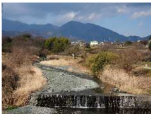
四十八瀬川（甘柿橋付近）
