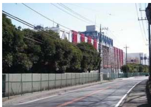
曾屋原地区の工業団地
