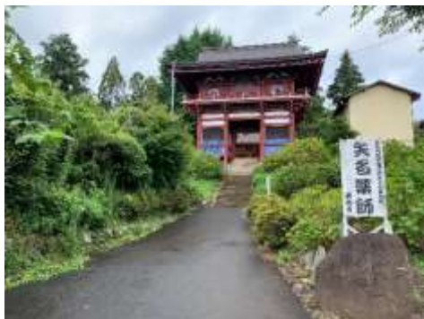
東光寺薬師堂山門
