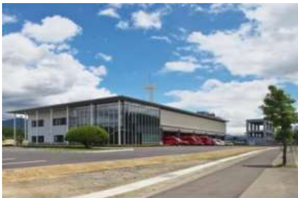
総合防災センター(遠野市消防本部)
