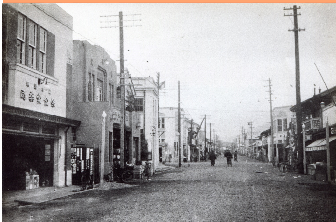
震災復興後の「四ツ角」付近
