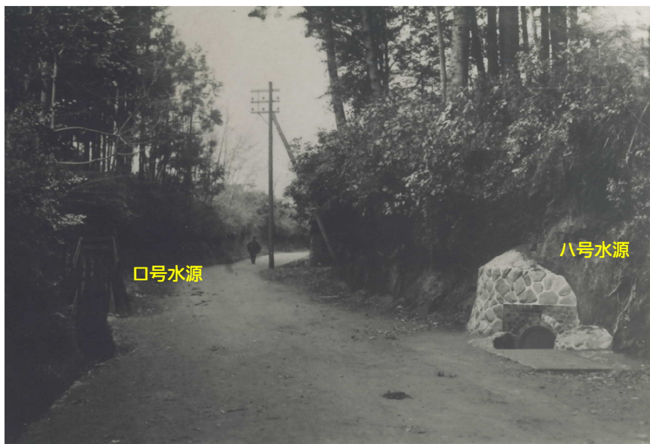
当時の曾屋水道の源泉入口付近
