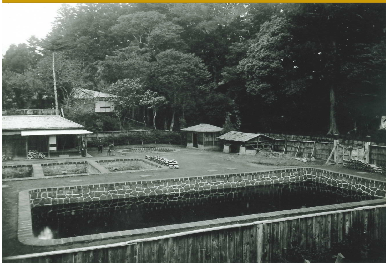
創設当時の浄水工場
