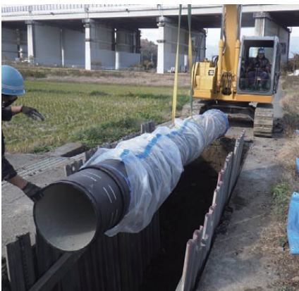
水道幹線管路耐震化の現場
