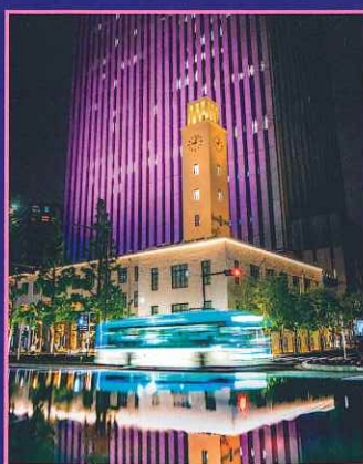
川崎市役所本庁舎
