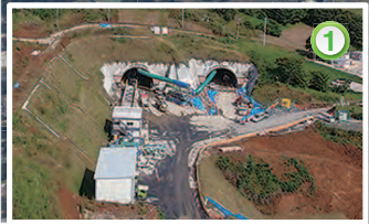
小原トンネルと工事用道路の造成
