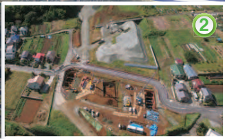
堀山下県道706号付近の橋の工事
