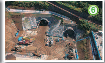
高取山トンネルの掘削を開始
