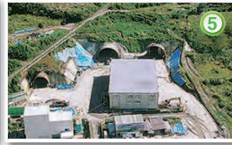
羽根トンネル下り線(右側)を掘削中
