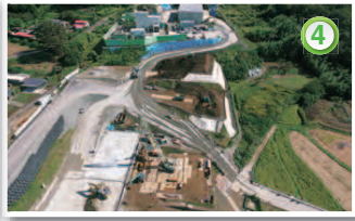
橋脚を作るための基礎工事
