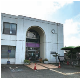
受水設備の修繕が行われたほうらい会館
