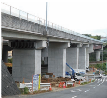
橋りょう工事の様子
