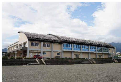
西中学校多機能型体育館
