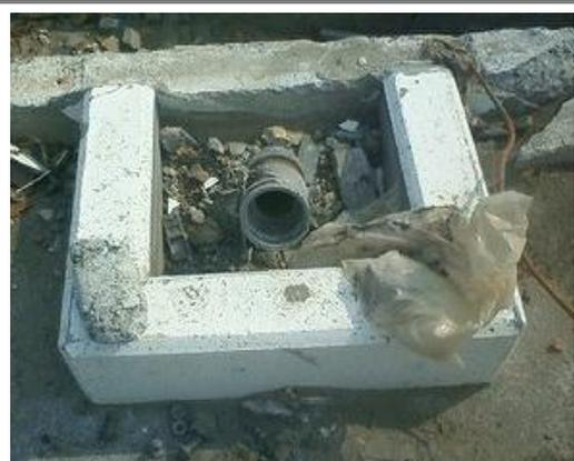
津波により破損した注入口
