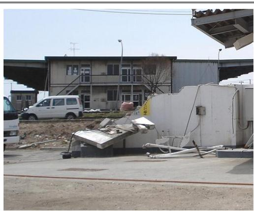
津波により破損した防火塀
