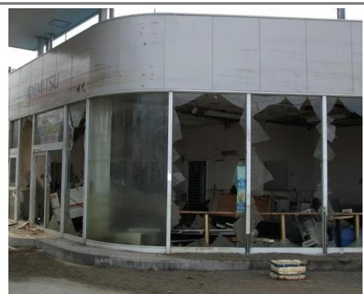
津波により破損した建築物(サービスルーム)
