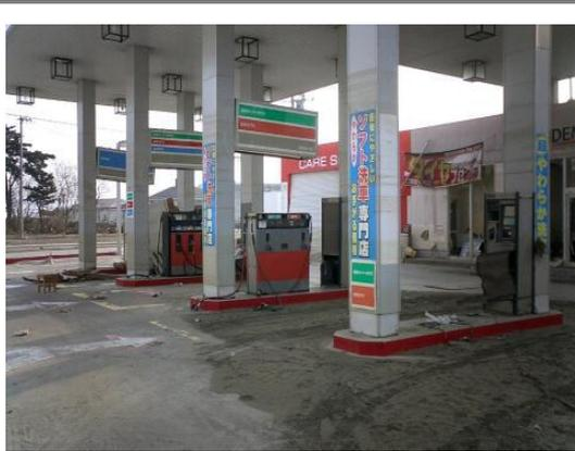
固定給油設備が欠損したアイランド
