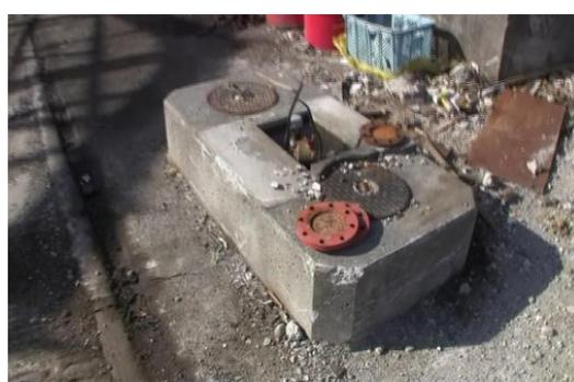
固定給油設備が欠損したアイランド
