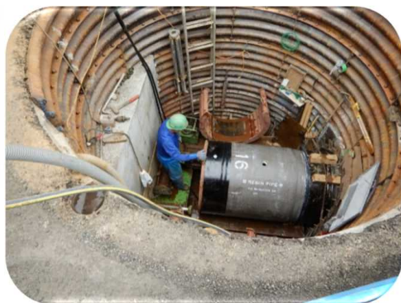
雨水施設の整備の様子
