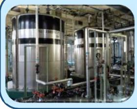
⑥ 最終沈殿池からの上面の水に次亜塩素酸ソーダを注入して、消毒し滅菌した後、金目川に放流します。
