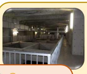
⑤ 反応タンクで処理された水と活性汚泥を分離し、きれいな上面の水は塩素混和地に、沈殿した汚泥は汚泥処理施設へ送ります。
