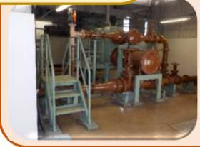
⑦ 最初及び最終沈殿池の汚泥は水分を多く含んでいるので、ここで静置し、水分を減らし汚泥の量を減らします。
