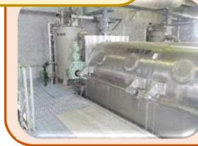
⑧ 薬品(高分子凝集剤)を加えた汚泥を手で握れる程度まで加圧脱水し、搬出します。(搬出後は、セメント等に活用します。)
