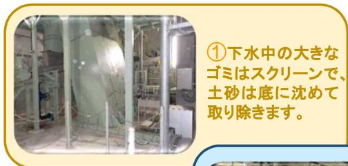
① 下水中の大きなゴミはスクリーンで、土砂は底に沈めて取り除きます。
