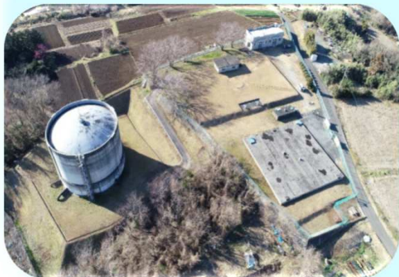
かないば 金井場配水場
