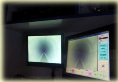
カメラを用いた管きよ内の破損等の調査の様子
