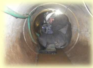
千村での雨水管工事の様子 (令和3年度実施)
