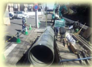
南矢名での雨水管工事の様子 (令和3年度実施)
