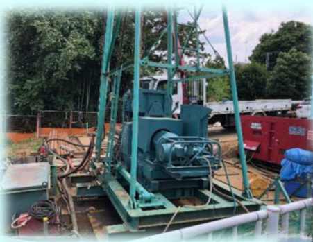
掘削後の井戸の洗浄及び揚水試験
