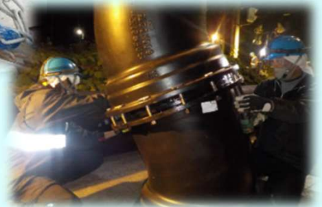
送水管(直径60cm)の更新・耐震化工事の様子
