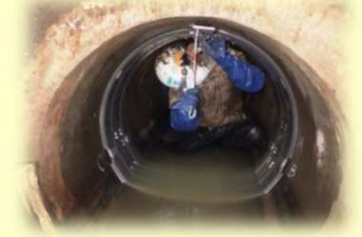
耐震化工事の 作業の様子
