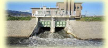
大根川ポンプ場(放水時)
