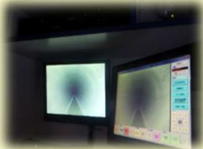
カメラを用いた管きよ内の破損等の調査の様子
