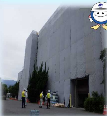
浄水管理センター改築工事
