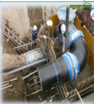
基幹管路の耐震化工事
