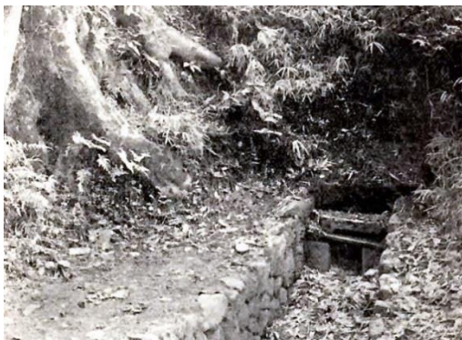
曾屋水道創設前から湧出していた水源（イ号水源）
