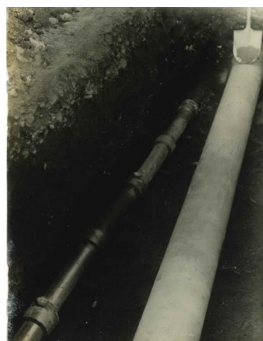
水道管理設写真 左側：陶管 右側：鉄管
