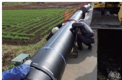
水道幹線管路耐震化工事の様子
