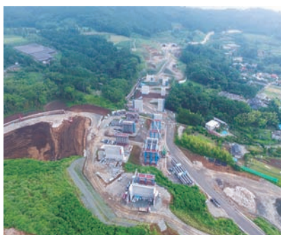
新東名高速道路建設工事の様子
