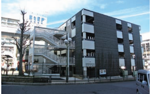
ペDESTリアンデッキと接続した秦野駅北口自転車駐車場
