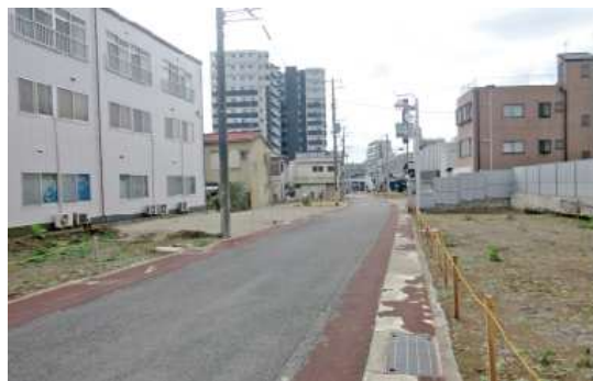
現在の様子 (拡幅整備中)
