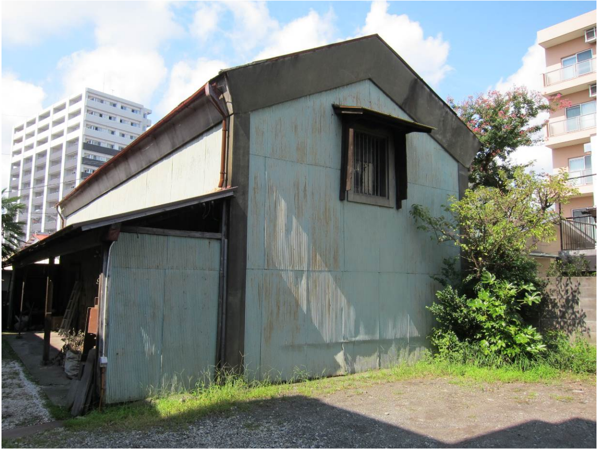
五十嵐商店第四号倉庫及び第五号倉庫 東側面
