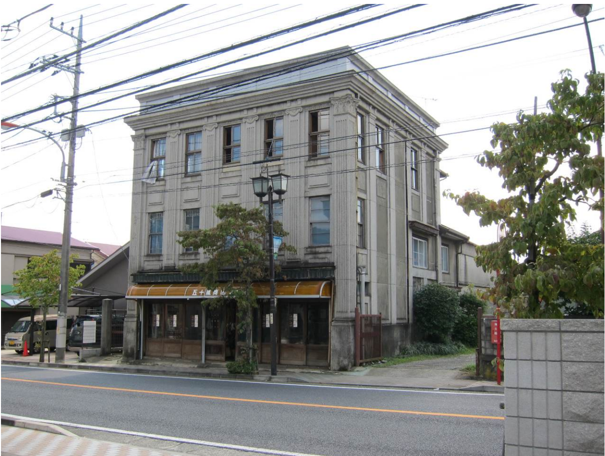
五十嵐商店店舗兼主屋 正面外観
