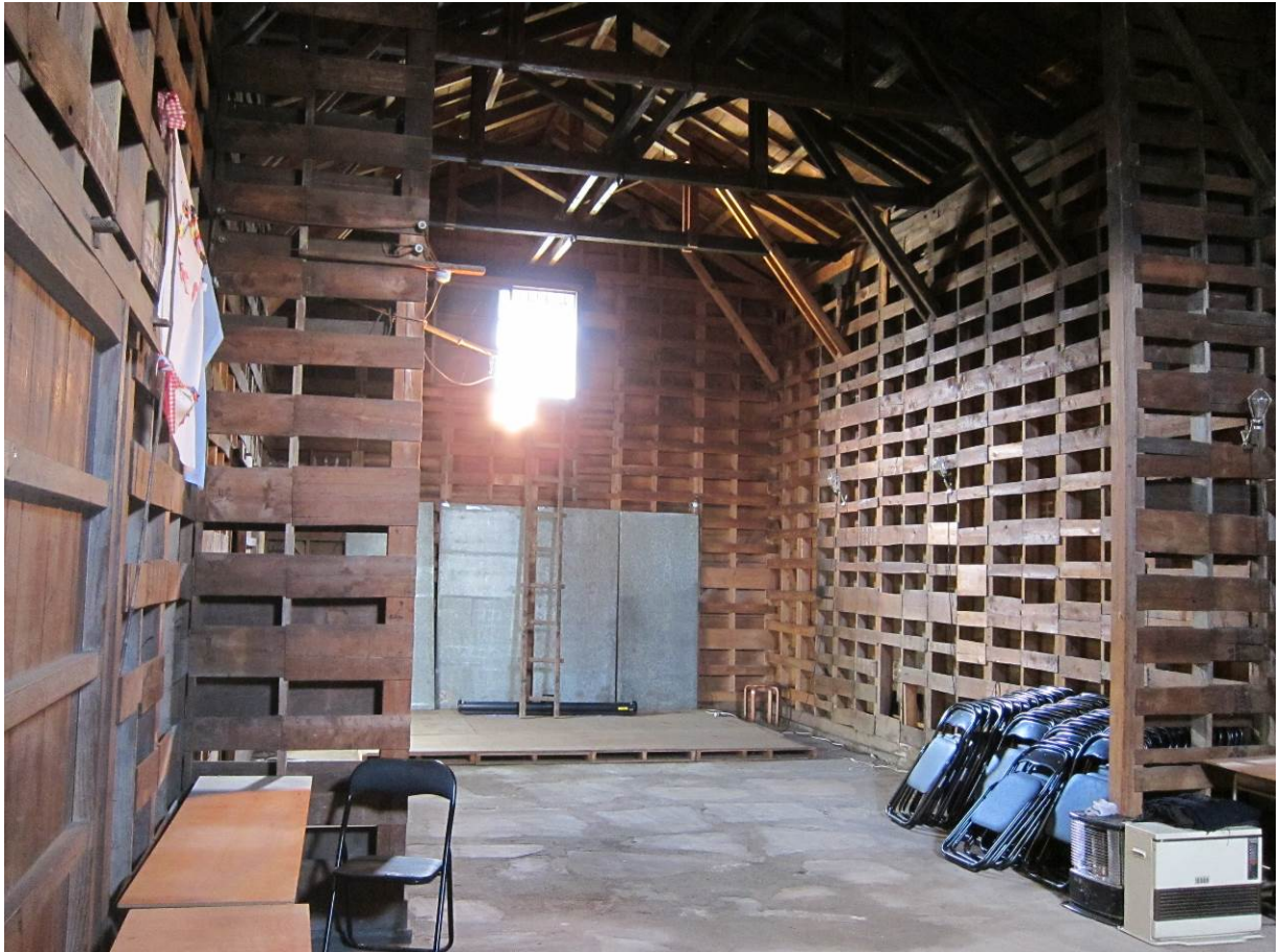
五十嵐商店第四号倉庫及び第五号倉庫 内観
