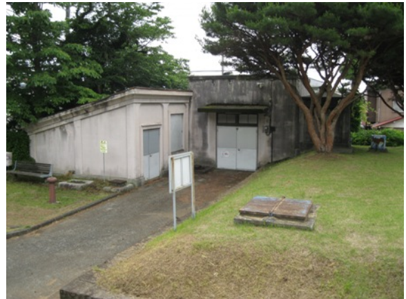
大正期ポンプ室 大正14年11月竣工
