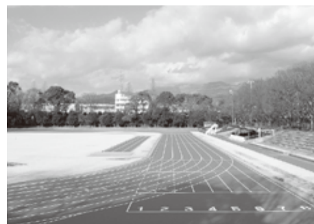
全天候型トラックに改修された陸上競技場
