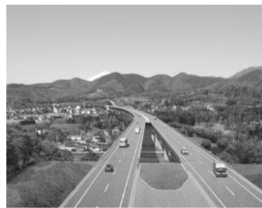
住民の安全確保が求められる新東名高速道路の工事(写真:新東名高速道路構想図)
