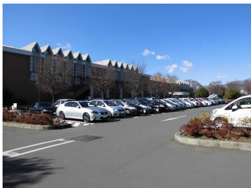
カルチャーパーク総合体育館(遠景)
