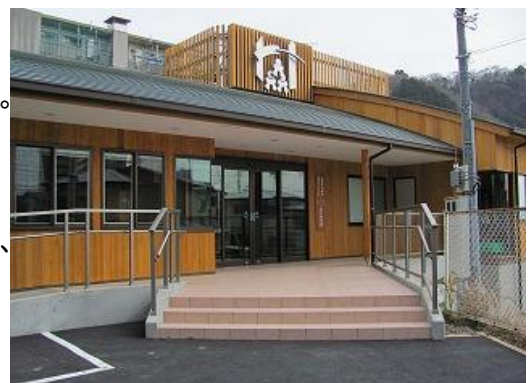
秦野市障害者日中サービスセンター「ひまわり」
