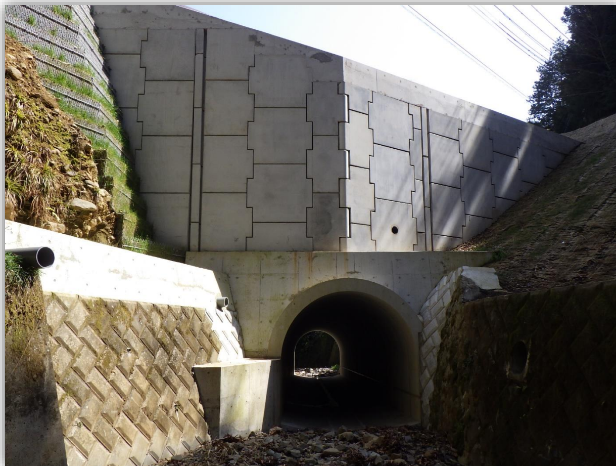
「市道 18 号線道路災害復旧工事」により復旧した護岸
