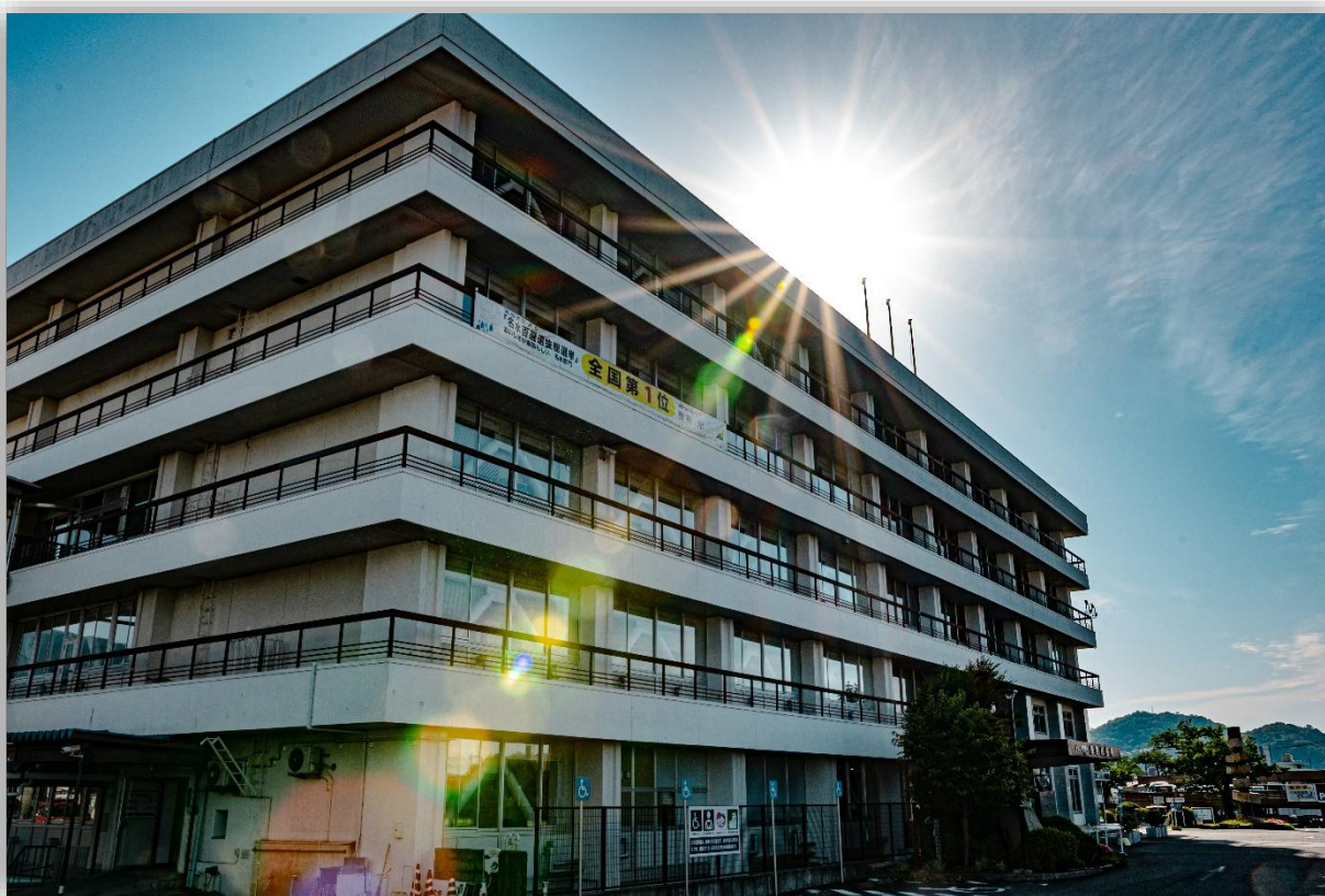
秦野市役所本庁舎
