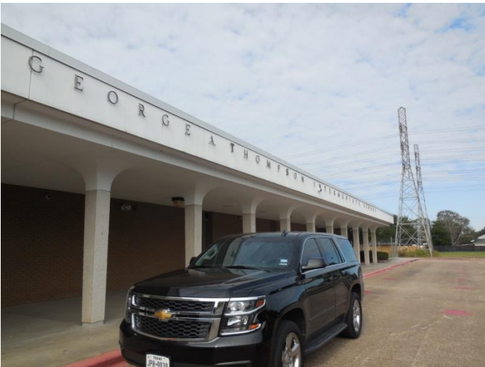
浸水被害に遭った旧トンプソン中学校 を訪問
