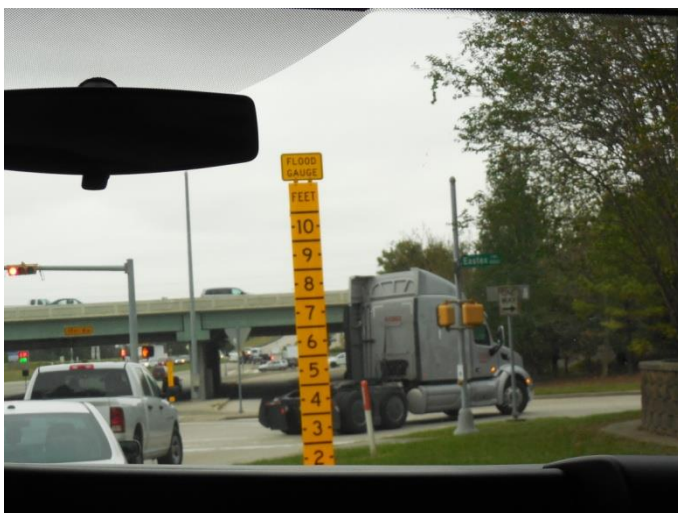
車移動の道中、浸水被害後から設置された という水深メーターを発見
