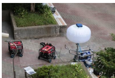
非常時の発電機と照明器の点検
