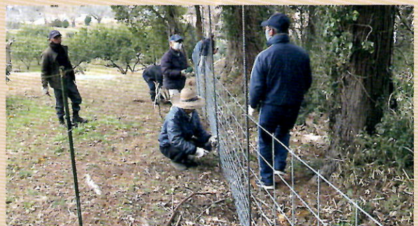
▶ 設置作業の様子
