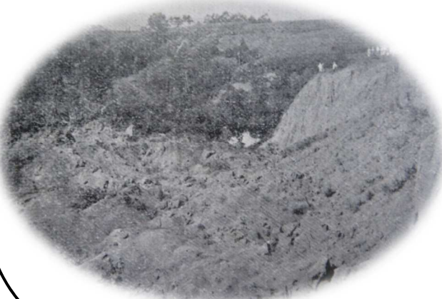
震生湖の土砂崩れ
