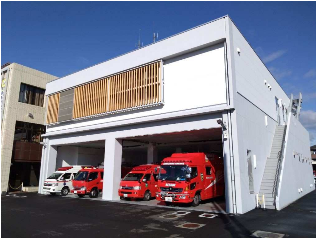
【秦野市・伊勢原市共同消防指令センター】 (令和6年2月完成・令和7年1月運用開始)
